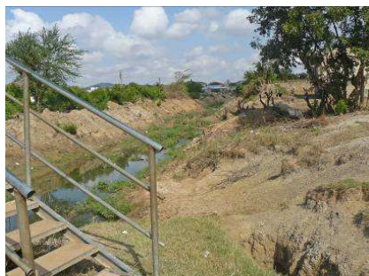
1 brug over rivier, andere ontbreekt
