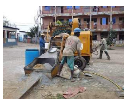
betonstorten voor de nieuwe werkplaats
