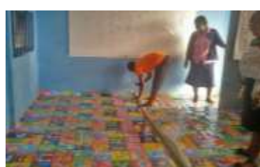
vloerbedekking in kleuterlokalen
